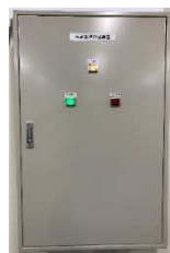
非常用発電機 自動切替装置
